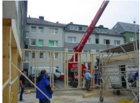
Abb. 4: Erweiterung in Holzständerbauweise
