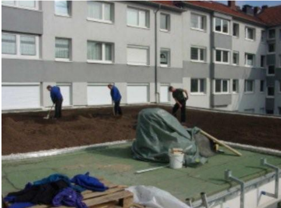
Abb. 7: Vorbereitung zur Dachbegrünung
