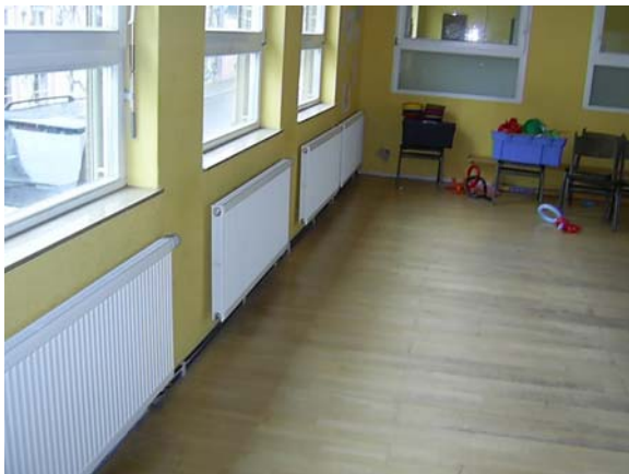
Abb. 1: Nach der Sanierung des alten Kindergartens
