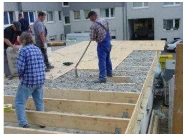
Abb. 5: Dämmung mit Zellulose
