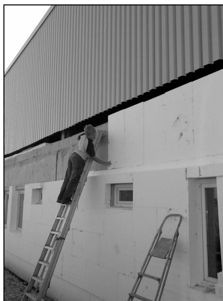
Abb. 1: Außenwanddämmung einer Flugzeughalle
